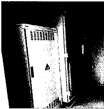
อินเวอร์เตอร์ศูนย์กลางรวม (Central Inverter)
